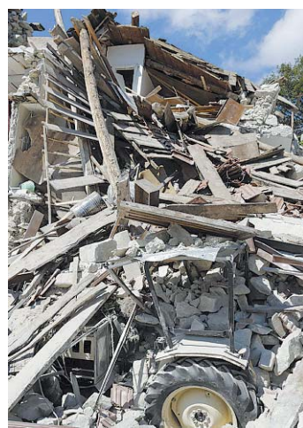
Terremoto Pescara del Tronto
